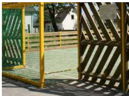
Accès PMR et Barre anti-2 roues
